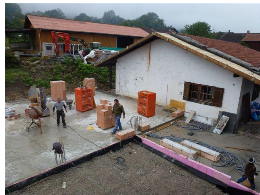
Foto: Start des Saalbaus beim DGH (Thomas Zink)
